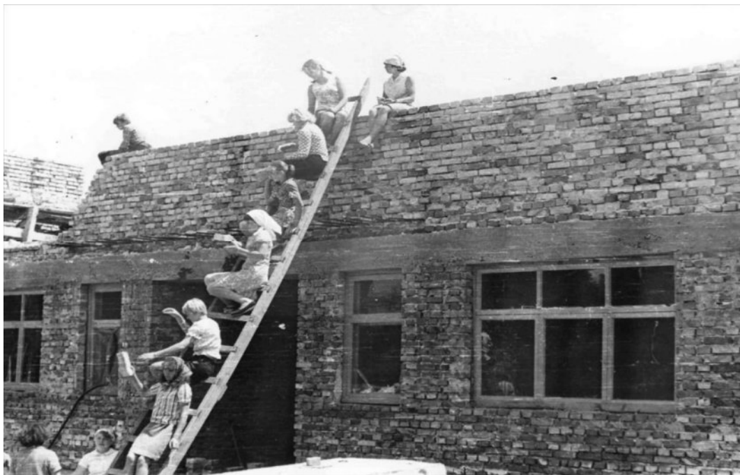
Фото 6: Будівництво шкільного музею.
