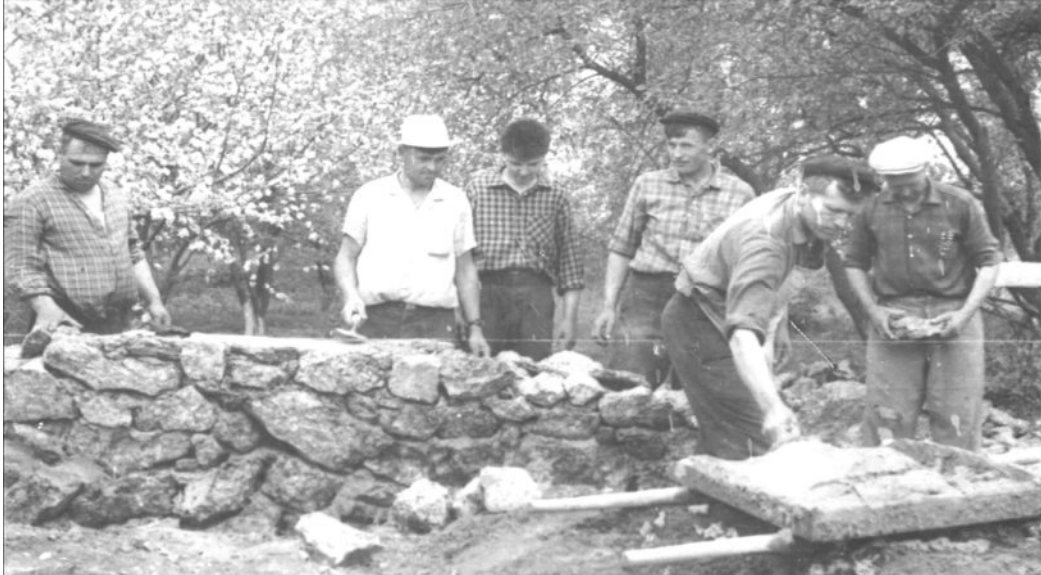
Фото 1. Батьки сахнівських школярів на будівництві фонтану «Колосок».
